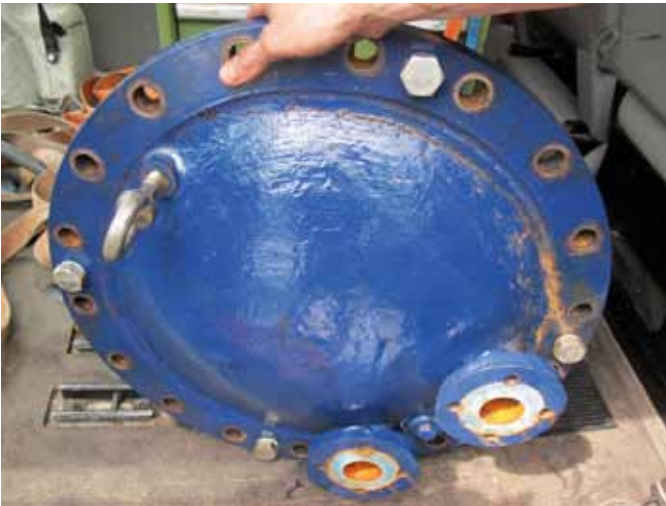
Der defekte Deckel am 8. Juni 2016.
