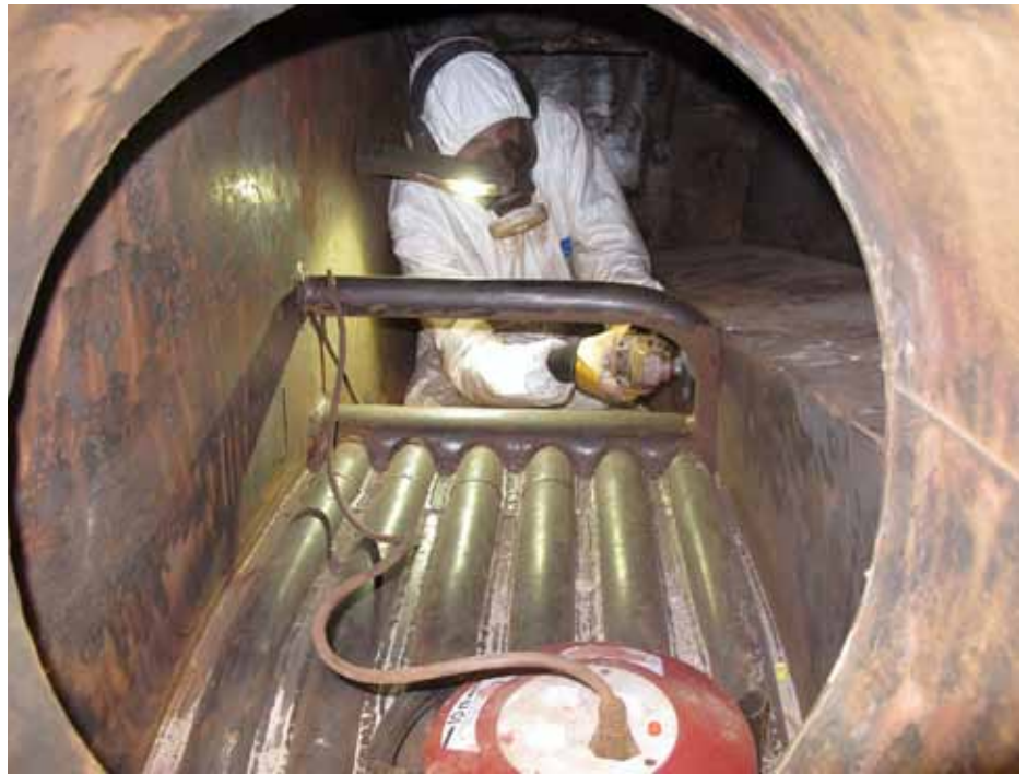
Der Kaminfeger russt die Heizung. Foto 7.3.2017
